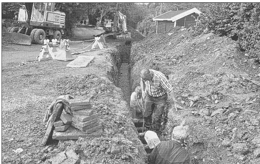
Vann- og avløp legges inn i hagen
